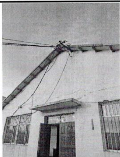
照片 4 监控装置
